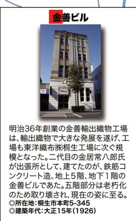
明治36年創業の金善輸出織物工場は、輸出織物で大きな発展を遂げ、工場は東洋織布㈱桐生工場に次ぐ規模となった。二代目の金居常八郎氏が出張所として、建てたのが、鉄筋コンクリート造、地上5階、地下1階の金善ビルであった。五階部分は老朽化のため取り壊され、現在の姿に至る。
