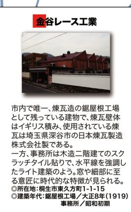
市内で唯一、煉瓦造の鋳屋根工場として残っている建物で、煉瓦壁体はイギリス積み、使用されている煉瓦は埼玉県深谷市の日本煉瓦製造株式会社製である。一方、事務所は木造二階建てのスクラッチタイル貼りで、水平線を強調したライト建築のよう。窓や細部に至る意匠に時代的な特徴が見られる。
